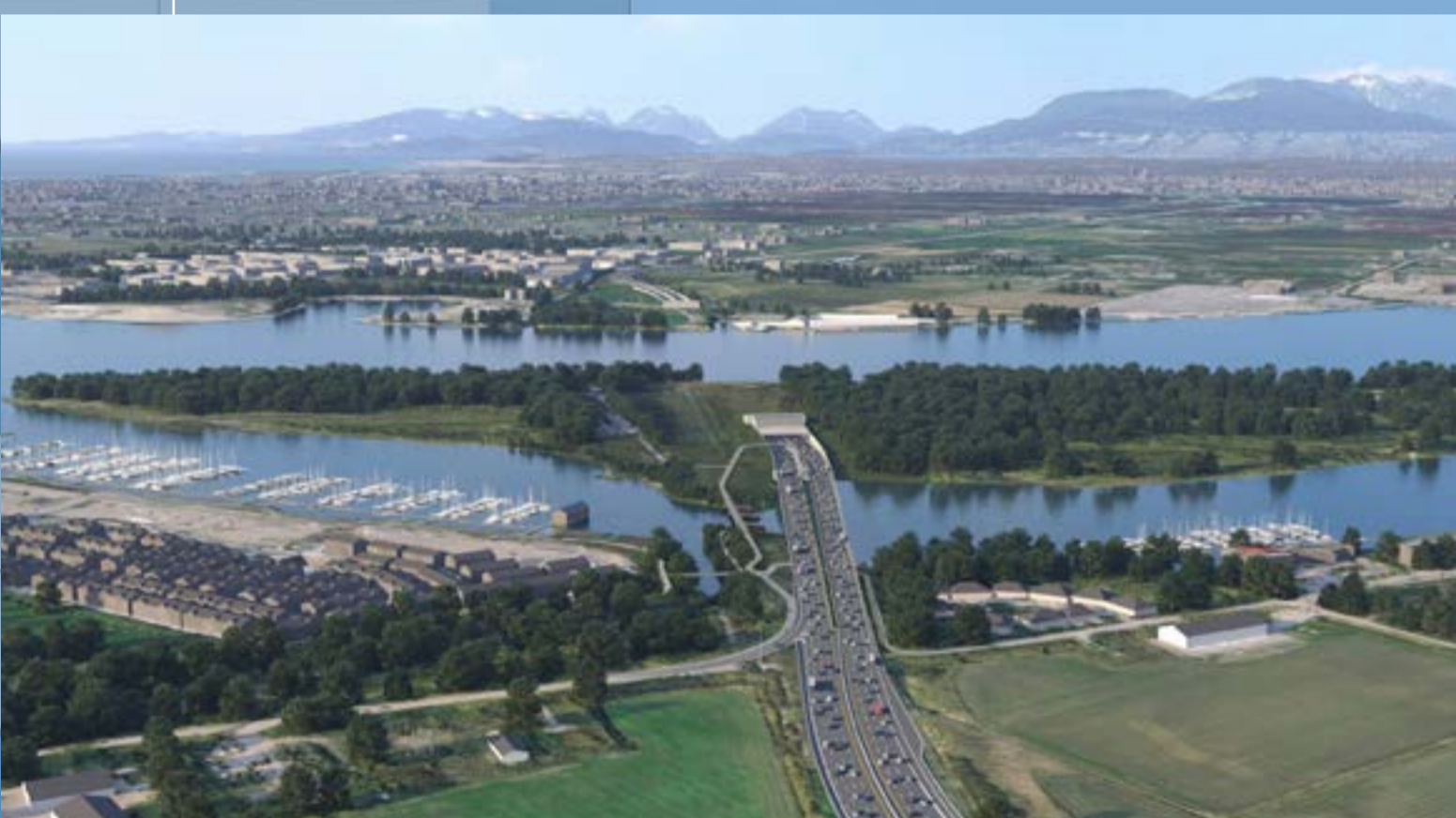
Fraser Tunnel en Canadá.
